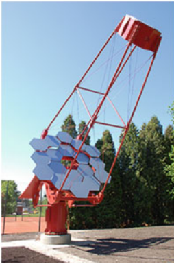
(d) Single-mirror SST prototype in Krakow.
